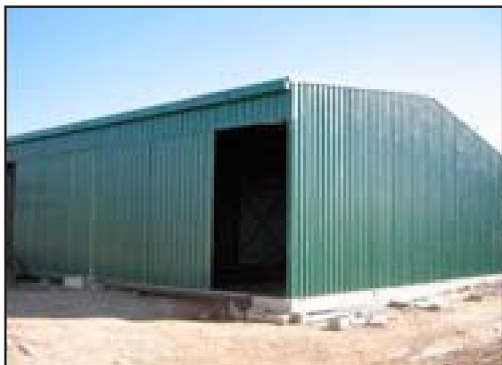
Imatge 33: Hangar. Font: DGMN.
